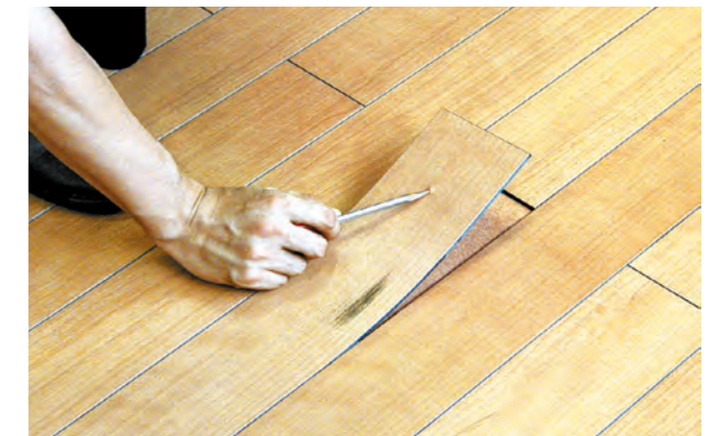
2 ビールアップボンドでの施工のため錐（キリ）等を使えば・・・
