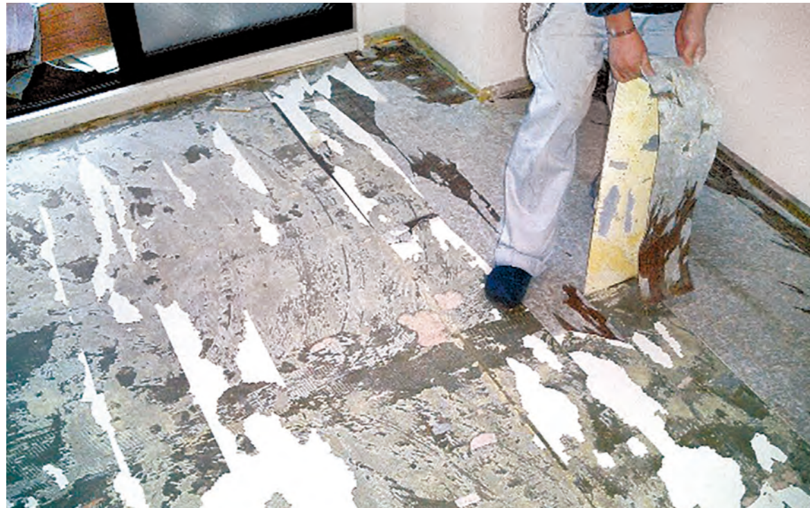
剥がし作業は大変な労力を伴う作業であり、また剥がした後の下地へのダメージも大きい。
